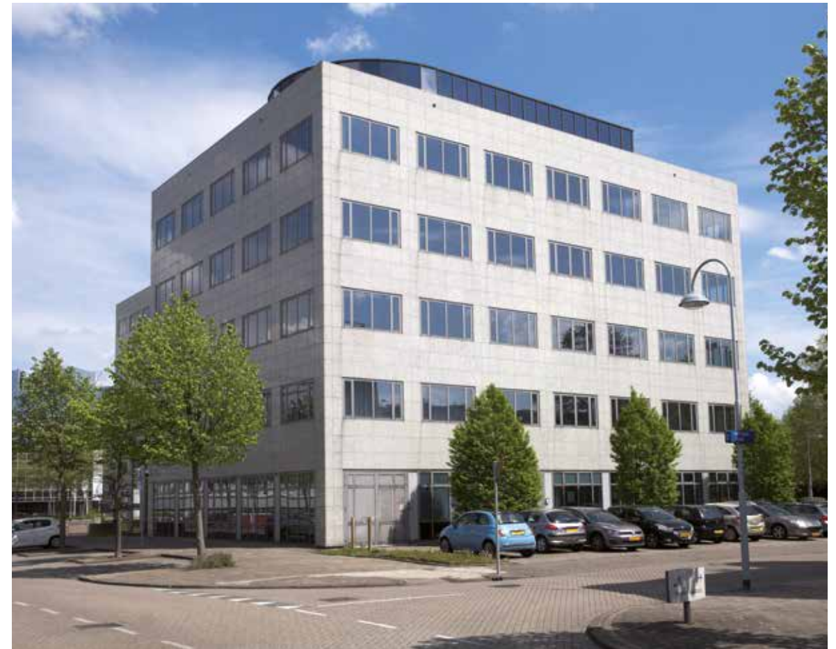
Het industriële kantoor. Het typische industriële kantoor heeft vaak een anonieme uitstraling en relatief kleine vloeren die als een soort donut om de centrale stijgpunten zijn geconstrueerd.
